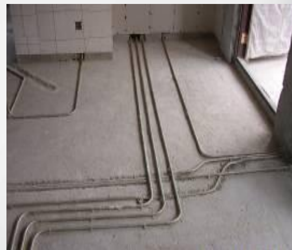
3. 管路连接、管路固定
