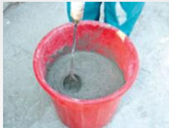
2.砌筑干粉搅拌、铺灰
