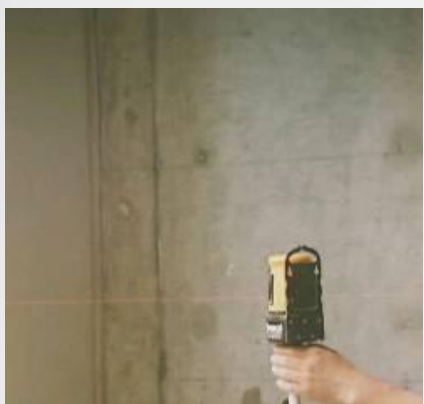
4.弹水平控制线
