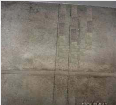
1. 放隔墙位置线
