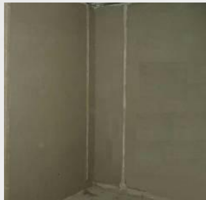
6. 满刮基层、面层粉刷石膏
