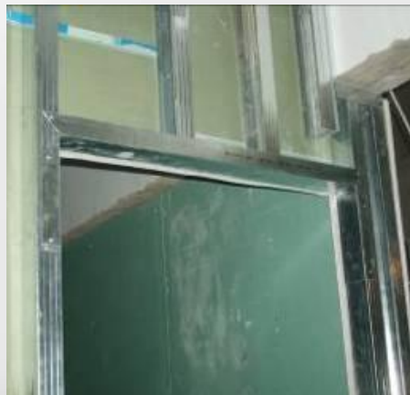
4. 安装门洞口框龙骨
