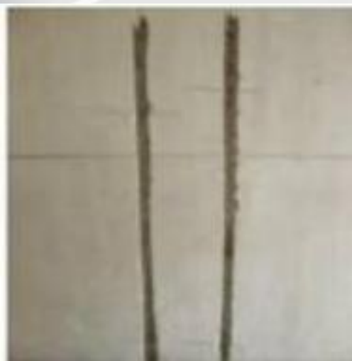
1.定位、放线、剔槽孔
