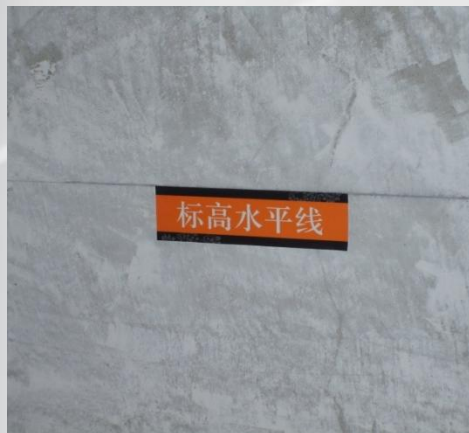
1.放吊顶水平线
