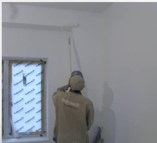
4. 涂刷面漆二遍
