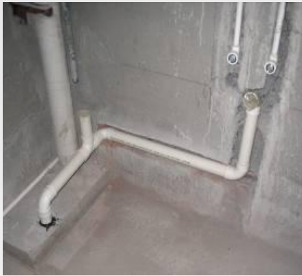
2.管路敷设、粘接、管路固定
