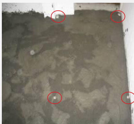
5.打饼、冲筋、 铺设成品砂浆
