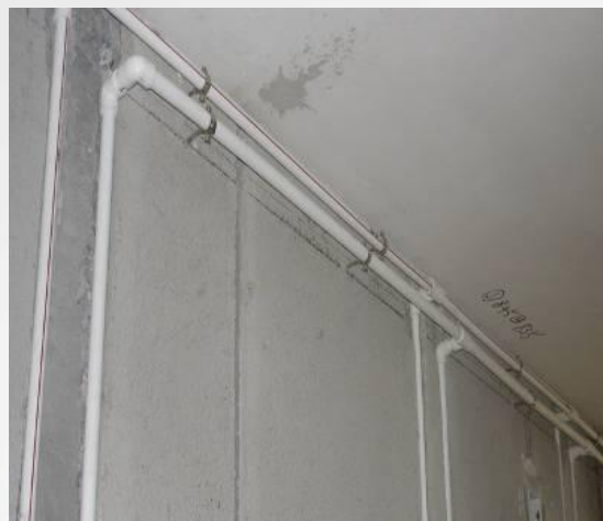
2.下料,布管,熔接,固定
